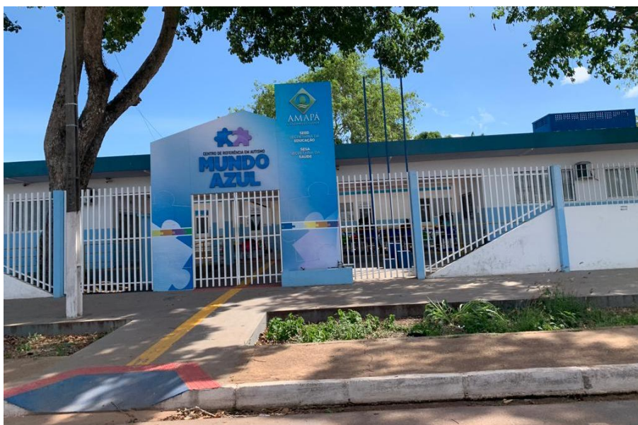
Fonte: Acervo EGL Engenharia (2022).
