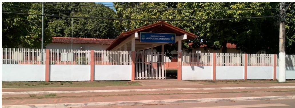
Fonte: Acervo EGL Engenharia (2022).
