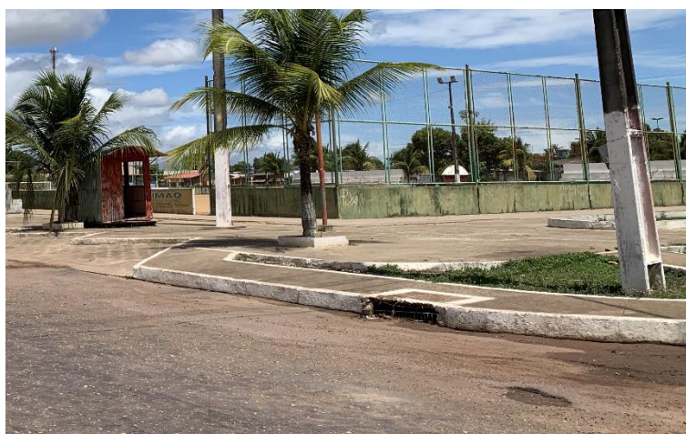
Foto 3.3 — Boca de lobo localizada na avenida Santana
