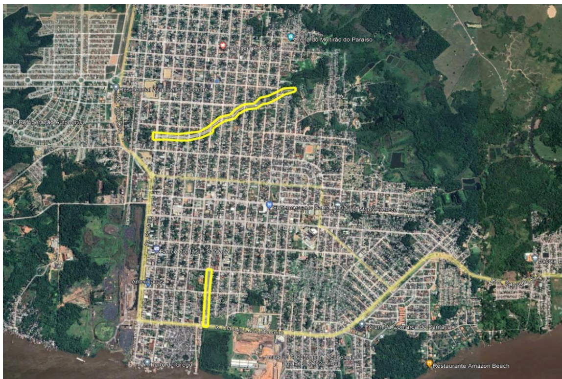
Figura 3.7 — Imagem aérea com localização dos canais de drenagem na zona urbana de Santana
