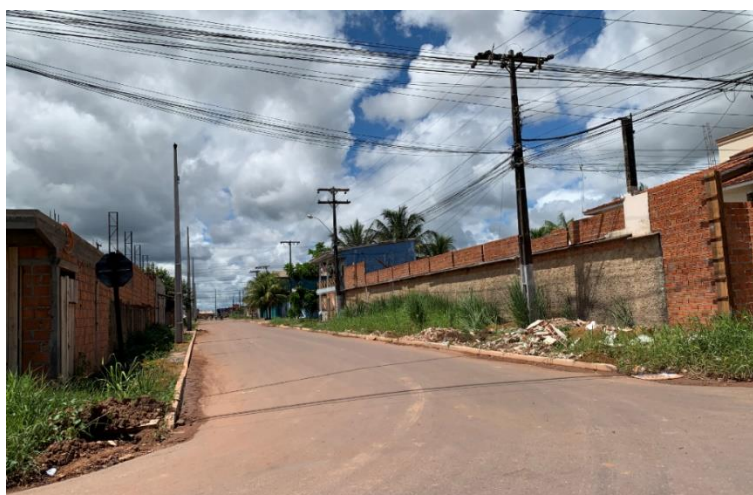
Foto 3.12 — Rua com meio-fio, mas sem calçadas adequadas
