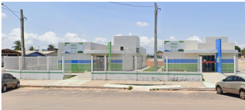
Foto 7.1 — Edifícios do CRAS e CREAS inaugurados em Santana, no bairro Paraíso
