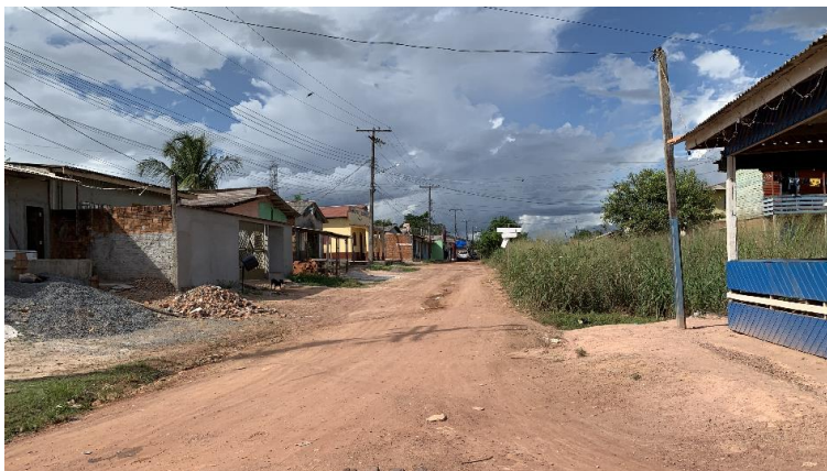
Foto 3.10 — Via local sem infraestrutura básica
