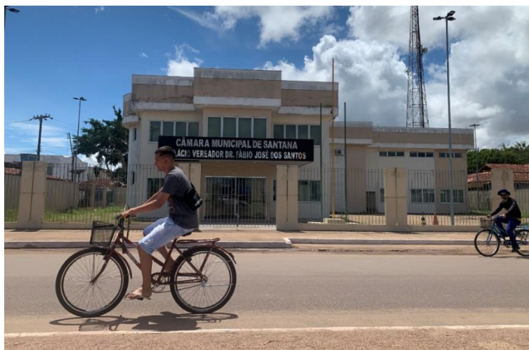
Foto 3.17 — Rua General Ubaldo Figueira, sem infraestrutura para ciclistas
