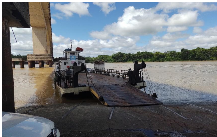
Fonte: Acervo EGL Engenharia (2022).
